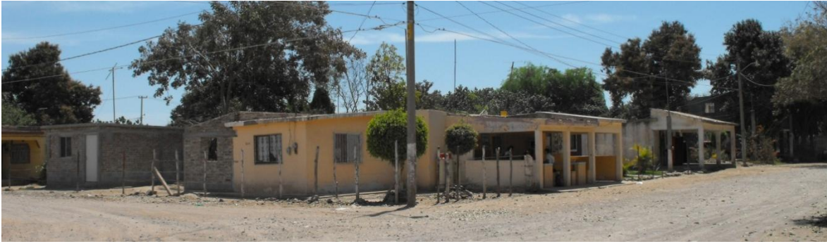
Fotografía de viviendas en la colonia centro, hacia el sur no hay pavimentación ni banquetas, tienen las características arquitectónicas más comunes de Higueras de Zaragoza, techos inclinados de concreto y muros de block o ladrillo
