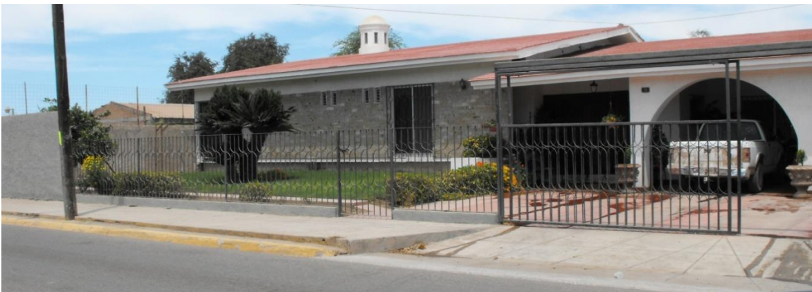
En la fotografía se ve una vivienda de nivel medio alto sobre la Av. 20 de Noviembre, el sistema constructivo es de muros de block de concreto y como cubierta losa maciza de concreto. Este tipo de vivienda es escasa dentro de Higueras de Zaragoza y se localiza sobre todo sobre las vialidades pavimentadas cerca de la zona centro.
