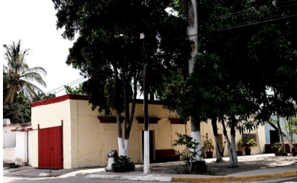
Fotografía de una casa colonial, cuenta con medidas bioclimáticas por su arquitectura vernácula, como techo plano, masividad en muros y materiales regionales.
