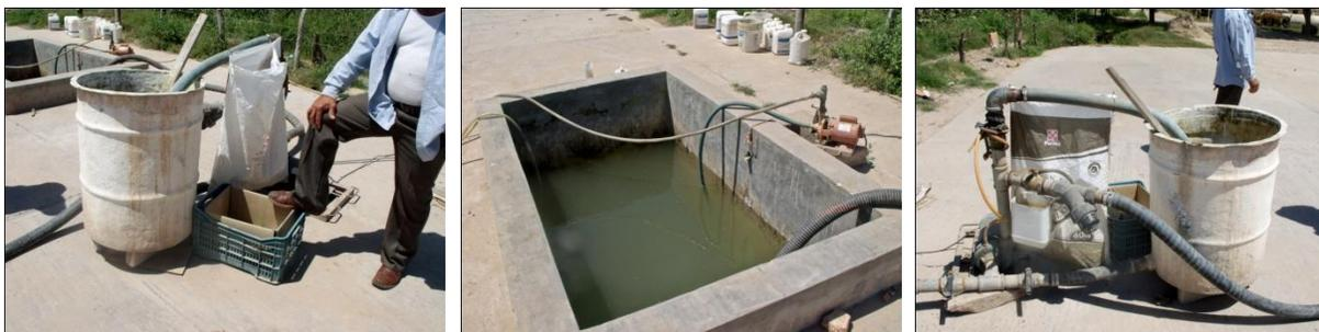
*Fotografías de las instalaciones y el equipo usado en el proceso de triple lavado y almacenamiento de los envases vacíos de agroquímicos.*
