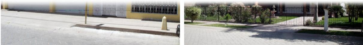
*Fotografías del sector centro, sobre vialidades que recientemente fueron recubiertas con adoquín y se puede observar que el nivel de banqueta y los acabados se mantienen.*
